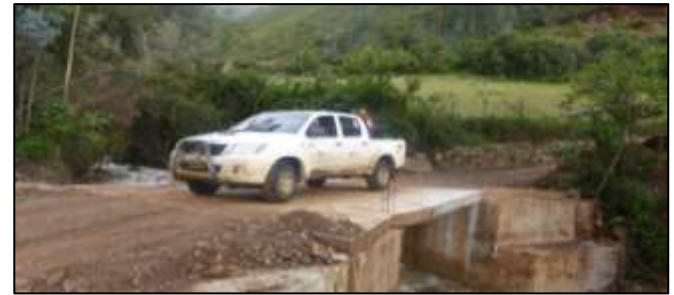
Puente en Los Alisos
