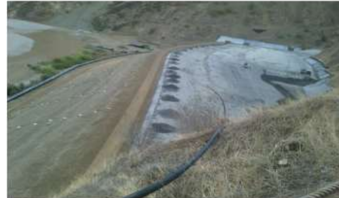
Deposito de relaves Santa María Disposición de relave en pulpa
