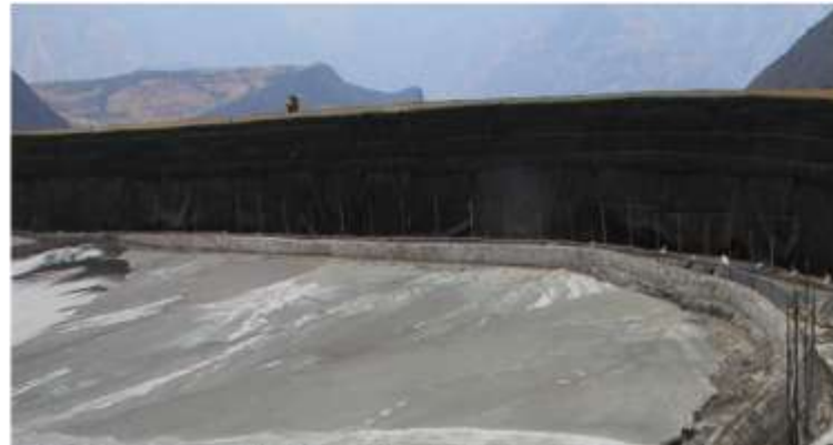
Deposito de relaves Santa María Disposición de relave en pulpa
